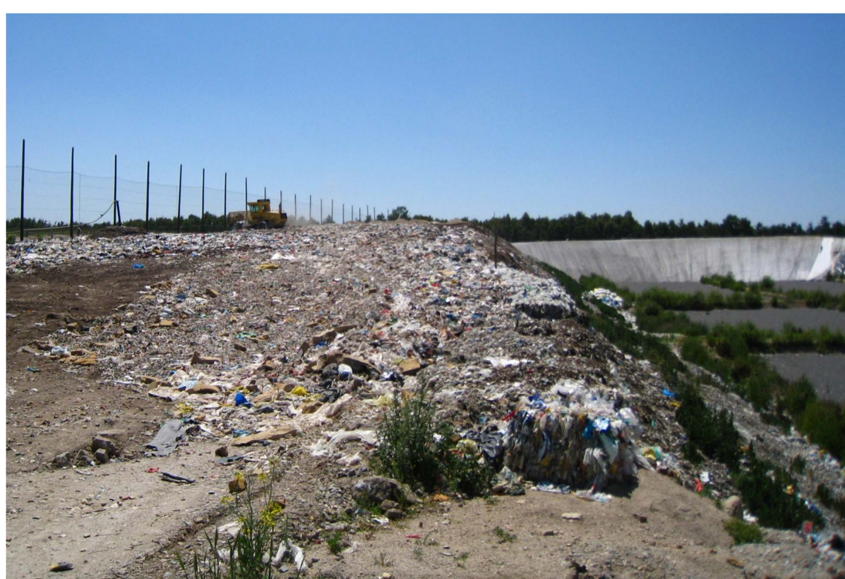
Installation de stockage – casier en exploitation (à droite casiers en cours d'aménagement)
