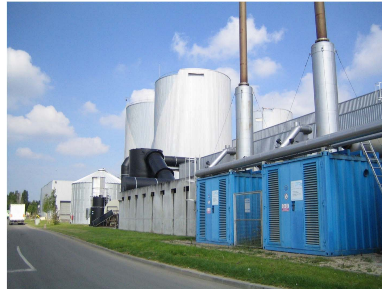
Vue générale : au premier plan, les moteurs, puis le biofiltre, le lavage acide et les digesteurs
